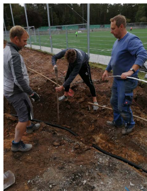
Verlegen der Leitungen für die neue Hütte.
